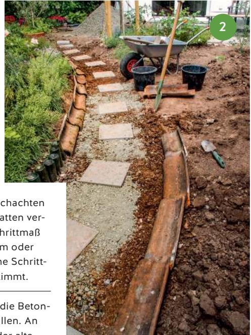
1. Erde ausschachten und Betonplatten verlegen. Im Schrittmaß von 60–65 cm oder auf die eigene Schrittlänge abgestimmt.
