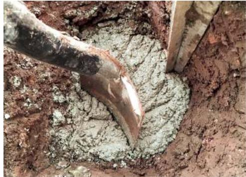
*Mit schnell härtendem Fertigbeton verfüllt.*
