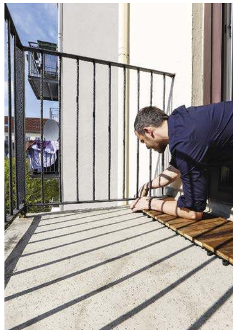
Nachher: Klickfliesen verdecken den Beton.
