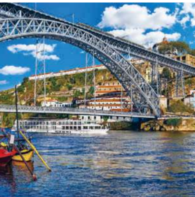
Portos Bogenbrücke Ponte de Dom Luis I.
