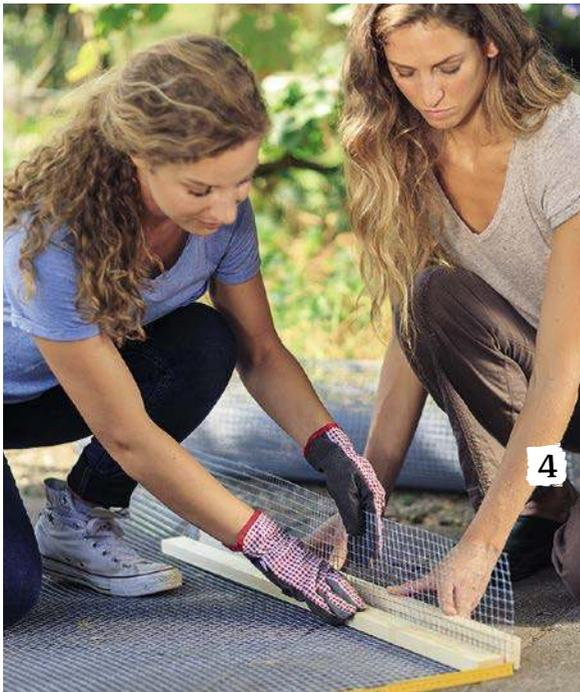
← Biegen Sie anschließend das Drahtgitter für den Boden an den Längsseiten hoch. Das geht am besten zu zweit: Einer drückt mit einer Latte das Gitter auf den Boden und biegt einen 10 cm breiten Rand nach oben, der andere hält mit einer zweiten Latte von außen dagegen. Dann biegt man man den Rand auf der gegenüberliegenden Seite hoch. Der mittlere Teil des Gitters muss so breit sein wie das Hochbeet lang ist, also 80 cm.
