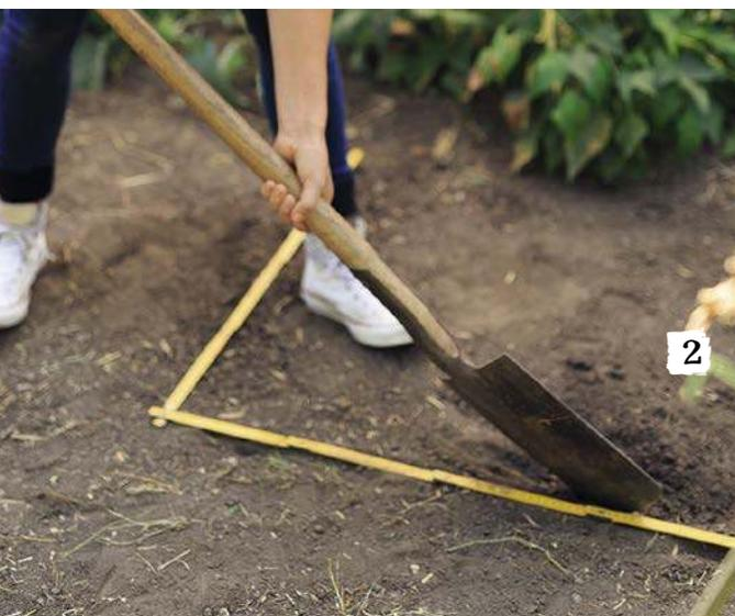
← Anschließend werden die Umrisse des Holzrahmens mit dem Spaten nachgezogen. Die Erde an dieser Stelle wird etwa 5 cm tief ausgehoben. Das ist notwendig, damit das Hochbeet bzw. das Drahtgitter später richtig im Boden sitzt.
