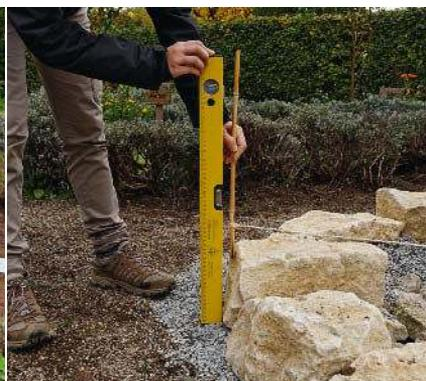
**3** Für die unterste Reihe wählen Sie quaderförmige Steine. Wichtig: Die Mauer muss eine leichte Neigung – etwa 10° – nach innen haben.
