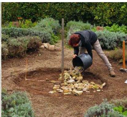
**2** Füllen Sie groben Schotter, Splitt, Kies oder anderes Gesteinsmaterial als Drainage ein, damit das Wasser abfließen kann. Diese Schicht stampfen Sie mit einem Vorschlaghammer fest.
