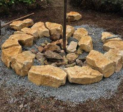
**4** Ziehen Sie keine freistehende Mauer hoch, sondern hinterfüllen Sie sie. Dazu füllen Sie den Kern der Spirale mit Abfallsteinen und Splitt auf.
