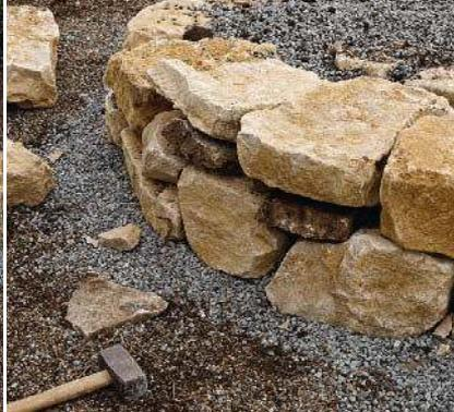
**5** Damit die Mauer stabil ist, sollten die Steine immer versetzt liegen. Große Fugen schließt man, indem man kleinere Steine mit dem Maurerhammer in die Zwischenräume klopft.
